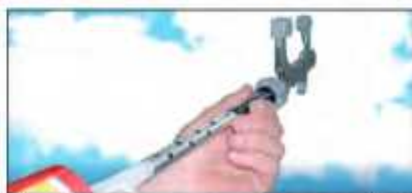
Si consiglia di avvitare l'accessorio sul tassello prima di inserirlo nel foro del muro così da rendere più semplice il suo posizionamento rispetto all'infilso e alla parete. Immettere anche un po' di ancorante chimico dentro il tubo forato del tassello.
